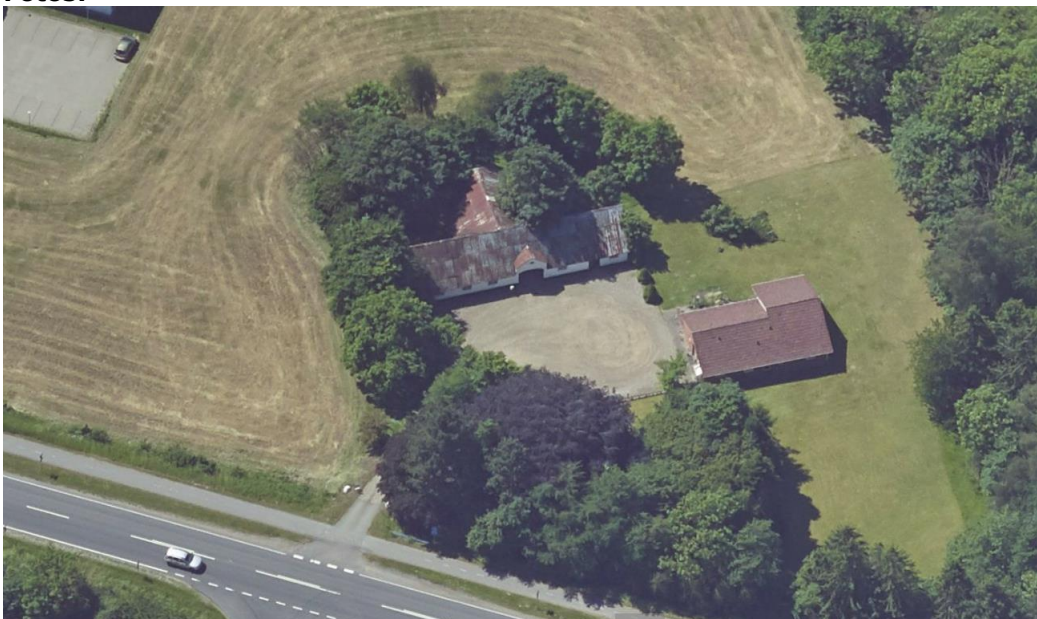
Skråfoto af ejendommen – Vejlevej forrest.
